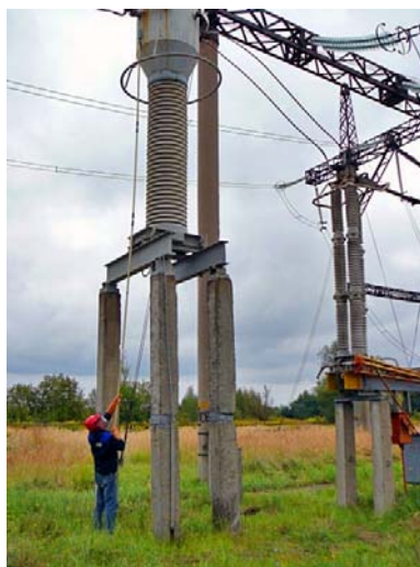
Рис. 7. Диагностика акустическим датчиком с радиоканалом
