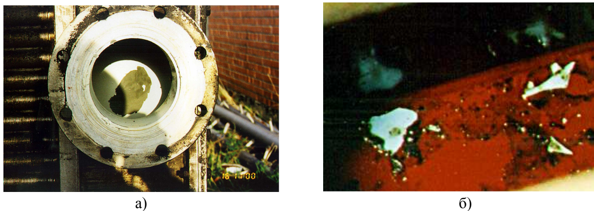
Рис. 3. Фрагмент внутренней поверхности маслопровода (а) и загрязнения в баке (б) трансформатора АSEC мощностью 400/400/100, напряжением 400/220/31,5 кВ.
